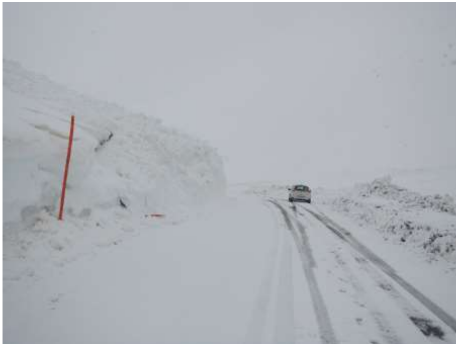
Doc. 1 : Vue de la zone des désordres depuis la chaussée
